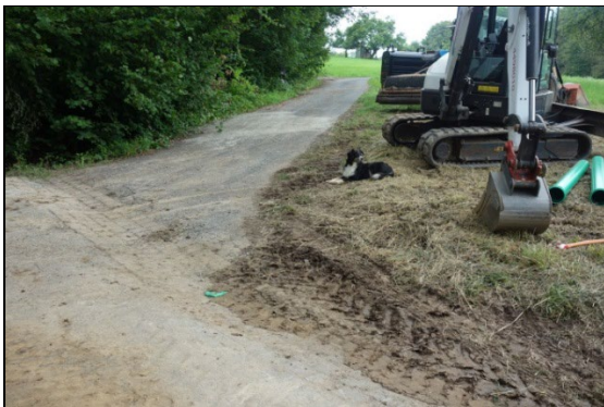
Zufahrtsbereich von der Krombacher Straße über den Wirtschaftsweg
