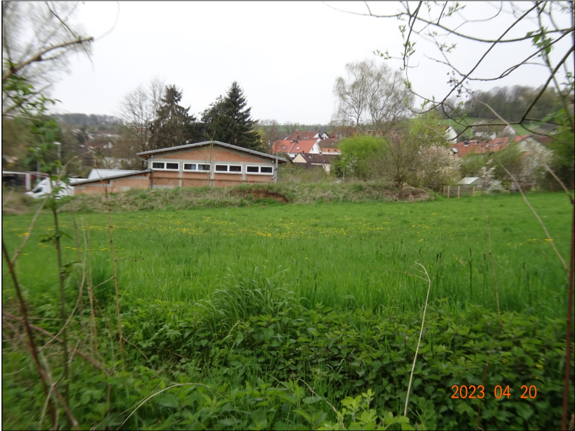
Blick Richtung Süden auf bestehende Turnhalle
